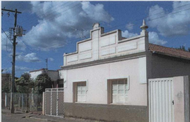
Foto 01 – Fachada principal; destacam-se a platibanda que remete ao estilo art déco e o pináculo à direita, sem equivalente do lado oposto.
