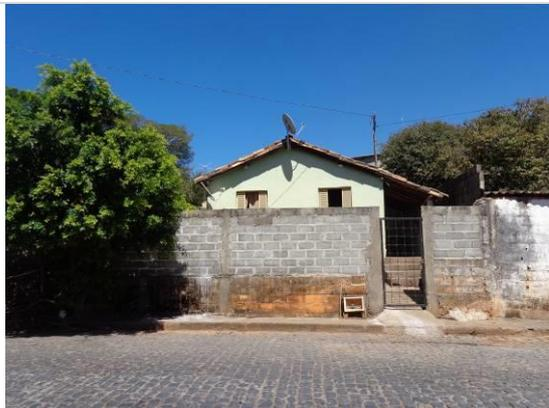
**Foto 1.** Vista do muro frontal em blocos de concreto sem revestimento ou pintura.
