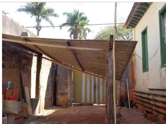
**Foto 5.** Cobertura de uma água de telha ondulada de fibrocimento para proteção de veículos.
