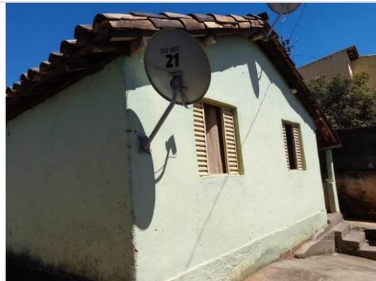
**Foto 2.** Fachada frontal com as janelas em veneziana. Telhas de capa e bica e cachorrada aparente.
