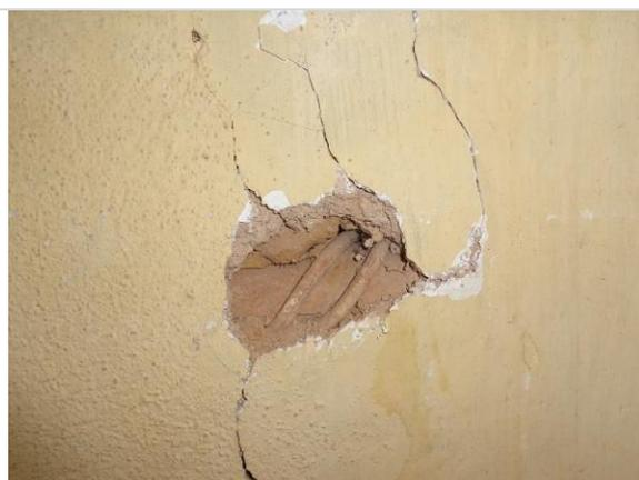
**Foto 10.** Perda de material de revestimento de uma das paredes internas. Destaque para a vedação em pau a pique. Peça roliça de madeira na horizontal.
