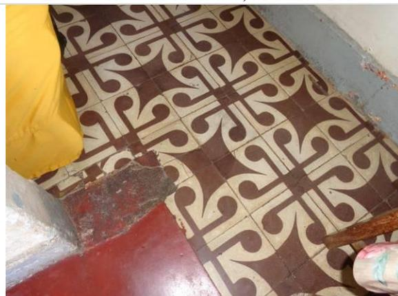
**Foto 8.** Piso de ladrilho hidráulico, transição da cozinha para o interior da residência. Destaque para marca no piso que aparenta retirada de trecho da parede.
