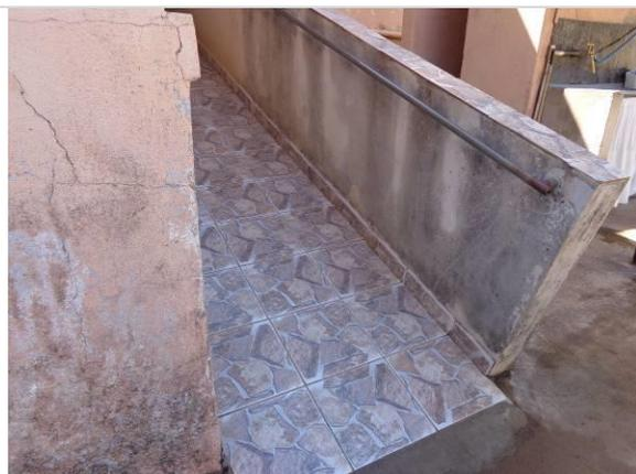
**Foto 10.** Rampa com revestimento cerâmico antiderrapante. Corrimão de tubo de ferro.
