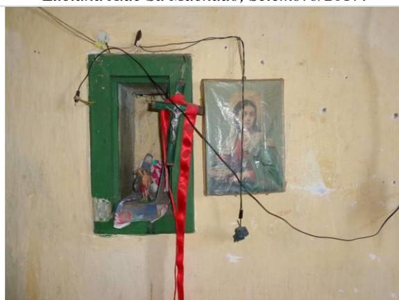
**Foto 12.** Fiação exposta sem proteção. Destaque para o oratório embutido na parede.
