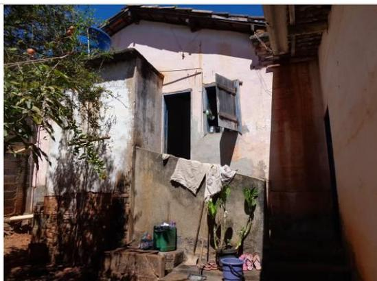
**Foto 3.** Fachada posterior. Destaque para o volume do banheiro em laje plana à esquerda.
