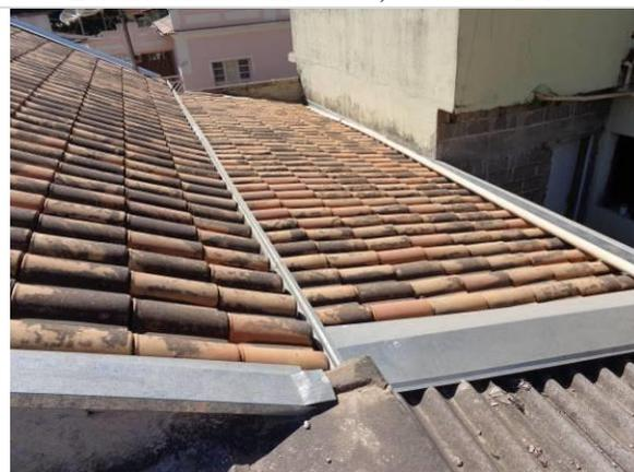
**Foto 14.** Telhas em capa e bica do volume principal e de parte da cobertura da garagem. Destaque para os rufos e calhas em ótimo estado de conservação.
