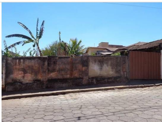
**Foto 6.** Trecho do muro com manchas de umidade e sujidade.
