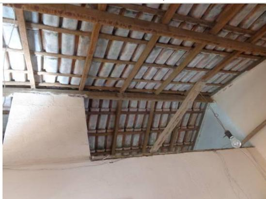
**Foto 5.** Cobertura sem forro. Engradamento em bom estado de conservação. Telha com camada de mofo.
