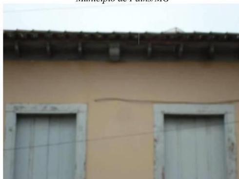
Foto 03 – Detalhe da fachada da Praça Juca Maneca, podendo-se observar fiação aparente fixada na alvenaria e beiral em cachorrada e guarda-pó.
