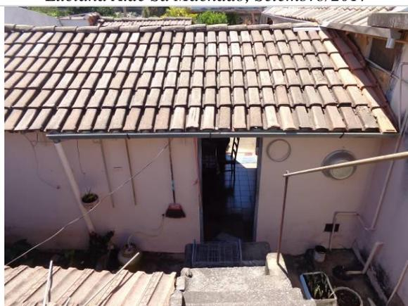
**Foto 9.** Vista da fachada posterior cozinha. Destaque para a calha em parte da extensão do beiral e tubulações aparentes.
