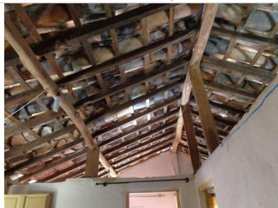
**Foto 4.** Cobertura interna sem forro. Detalhe para as peças roliças e emparelhadas.
