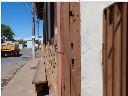
**Foto 4.** Detalhe do entalhe no esteio que remete a antigo fechamento da lateral direita.
