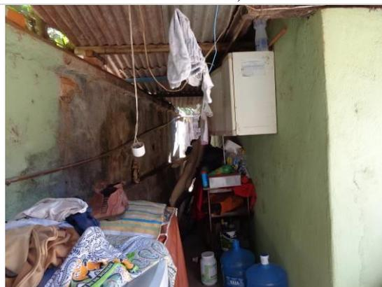
**Foto 6.** Fachada posterior. Destaque para o muro com manchas de umidade e sujidades.
