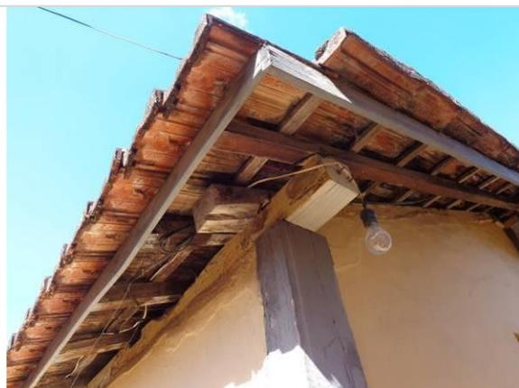
**Foto 14.** Beiral sem forro e com perda da telha da extremidade. Estrutura do telhado com manchas de umidade e micro-organismo. Fiação exposta entre os caibros.
