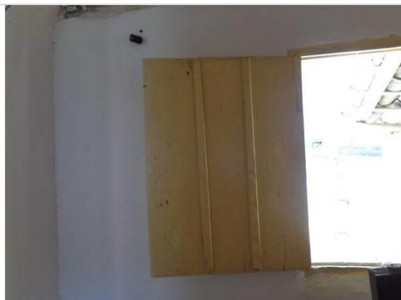
**Foto 8.** Detalhe da janela original da edificação. Folha cega de madeira e abertura de giro.
