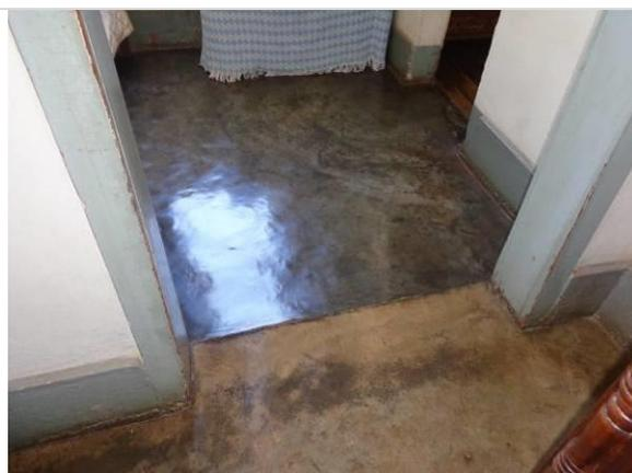
**Foto 9.** Piso de cimento queimado polido. Destaque para as tonalidades diferentes do cimentado.
