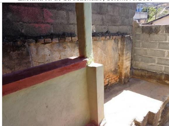
**Foto 9.** Destaque para o muro de divisa original constituído de tijolos maciços. Acabamento de topo com tijolos em sentido transversal.
