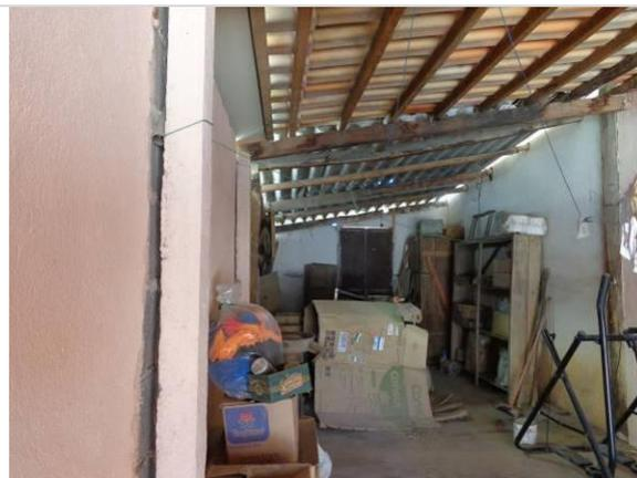
**Foto 4.** Antiga garagem. Destaque para os tipos de telhas e engradamento da cobertura.
