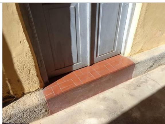
**Foto 4.** Soleira revestida com cerâmica retangular na cor vermelha. Destaque para a porta de duas folhas de giro.
