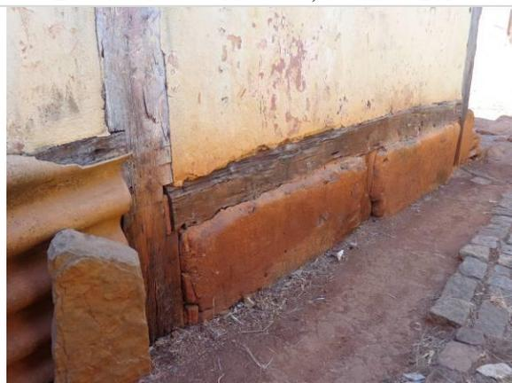
**Foto 6.** Vista da estrutura independente da lateral direita da edificação. Baldrame e esteio em bom estado de conservação.
