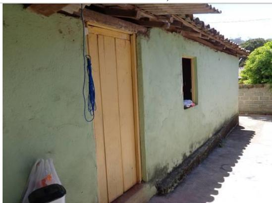
**Foto 5.** Lateral esquerda com as esquadrias originais. Folhas cegas de madeira pintadas de amarelo.
