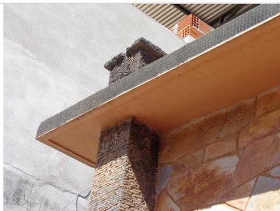
**Foto 4.** Destaque para o preciosismo dos detalhes de acabamento. Face do beiral revestida com pastilhas, beiral com pingadeira, pedras em filetes e mosaico de retalhos de pedra revestindo alvenarias.
